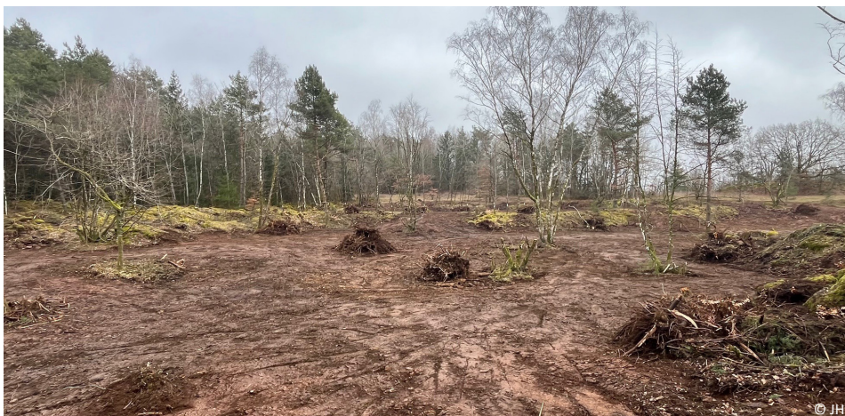
Après le chantier à Léiffrächen
